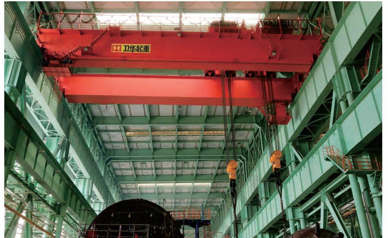
800吨双梁桥机 800tons double girder overhead crane
